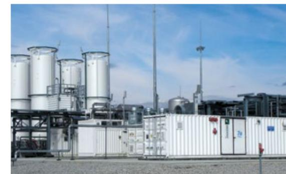
Эта технология фирмы CRYOTEC позволяет эффективно осваивать и эксплуатировать небольшие источники природного газа. Для транспортировки к месту назначения природный газ с помощью этой технологии очищается, высушивается и сжимается (СПГ) в непосредственной близости от источника или трубопровода.
